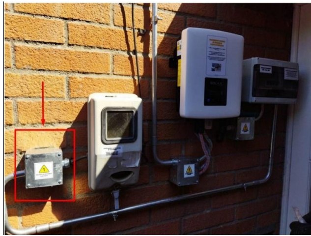
Figura 12-3 Ejemplo de caja de derivación donde se encuentra la extensión.
