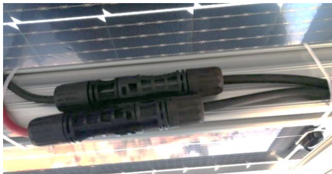
Figura 11-2 Conectores MC4 correctamente instalados y fijados.
