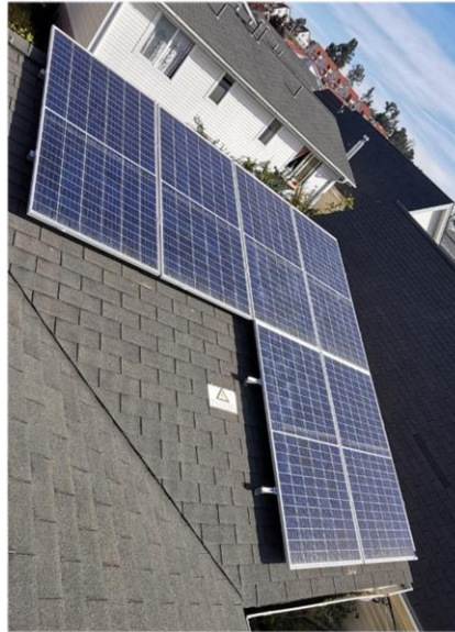
Figura 7-1 Distribución en L de proyecto de 2 kWp.
