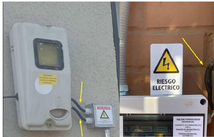
Figura 12-2 Tramo caja de derivación y empalme.
