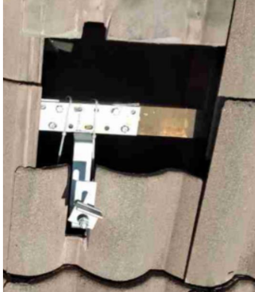
Figura 10-4 Anclaje fijado a la estructura del techo.
