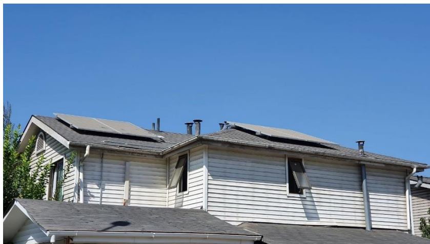
Figura 7-2 Distribución en dos aguas diferentes de proyecto de 2 kWp.
