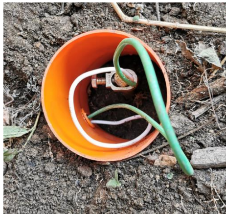
Figura 13-1 Conductor de tierra hasta el electrodo.
