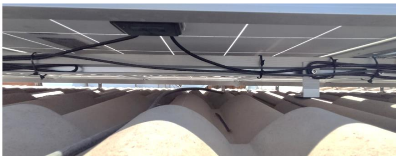
Figura 11-3 Correcta sujeción del cableado.
