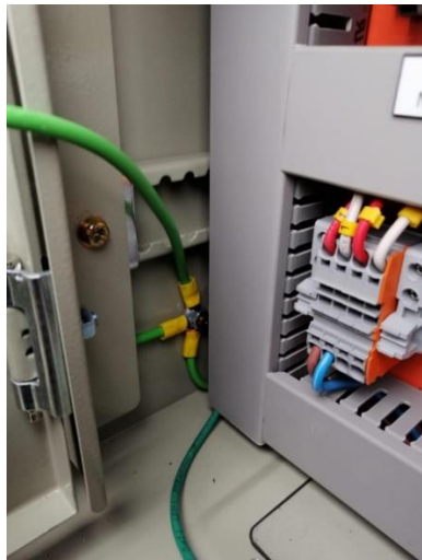
Figura 11-8 Puesta a tierra de tablero FV.
