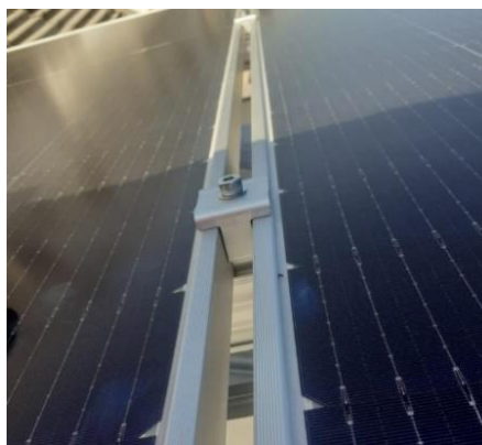
Figura 11-1 Grapa de fijación de paneles fotovoltaicos.
