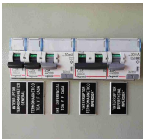
Figura 11-10 Rotulado de protecciones.
