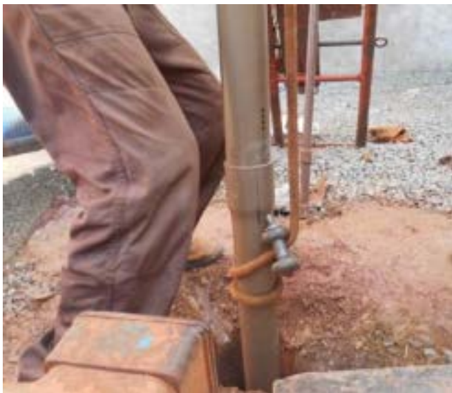
III) Instalação dos tubos de PVC
