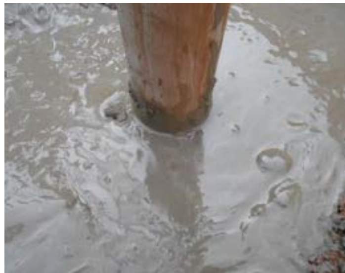
IV) Preenchimento com calda de cimento
