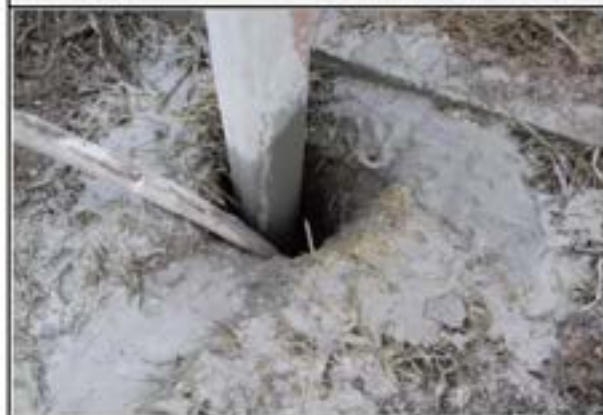
LANÇAMENTO DA CALDA DE CIMENTO
