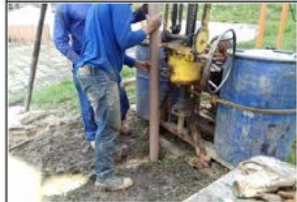
TUBO INSERIDO ATÉ PROFUNDIDADE DE 23,50 METROS
