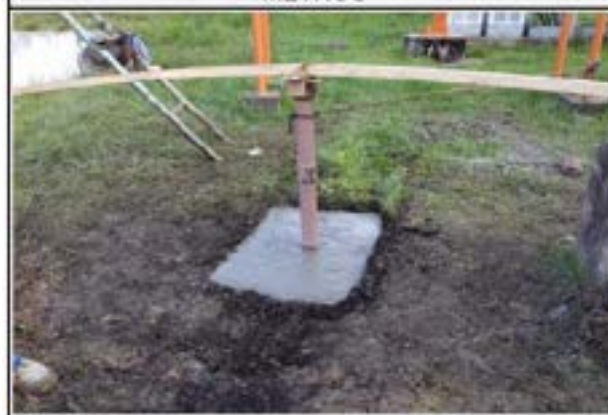
TUBO INSERIDO ATÉ PROFUNDIDADE DE 23,50 METROS
