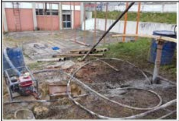
LANÇAMENTO DA CALDA DE CIMENTO
