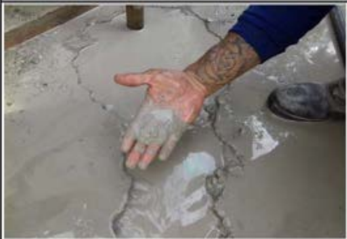
MATERIAL ENCONTRADO COM COTA DE 9,0 M
