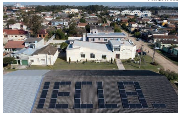
As placas desenharam a marca IECLB no telhado da Comunidade
