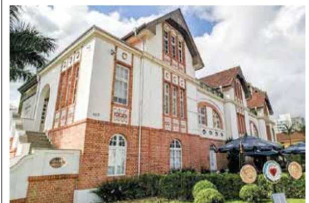
O belo prédio histórico será integrado à Escola Barão
