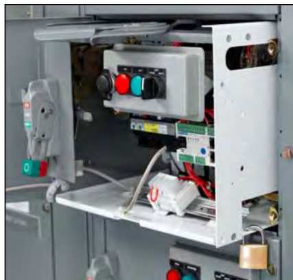
Figura 97 – Dispositivo bloqueado
