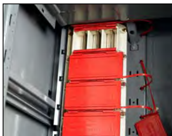
Volet manuel des barres-bus
