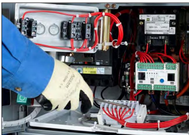
Figure 79 – Borniers détachables
