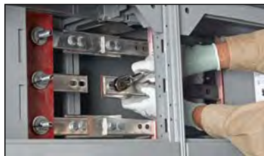
Figure 32 – Retrait des boulons d'une barre à raccordement simple
