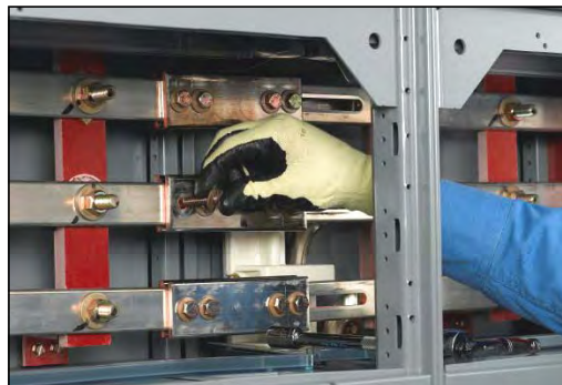
Figure 40 – Mise en place d'une rondelle conique sous la tête du boulon
