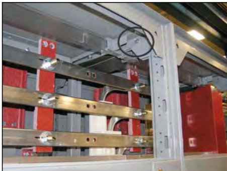
11F: Connexion du profilé latéral avant
