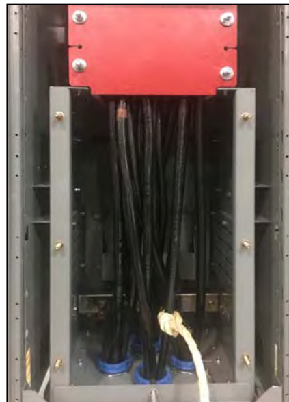
Figura 66 – Primer bucle de sujeción de cables
