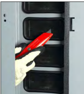
Figura 78 – Roldana aislante de la canalización de cables vertical
