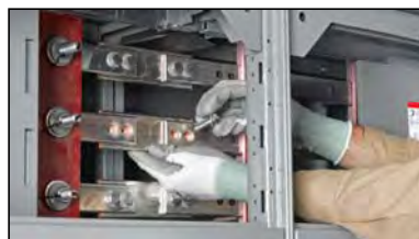
Figure 33 – Déplacement et alignement de la barre de raccordement avec les trous de la barre-bus
