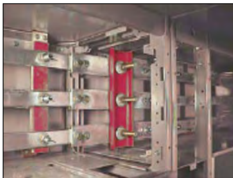
Figura 44 – Soportes de refuerzo opcionales de 85 000 A
