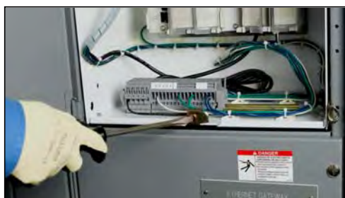
Figure 92 – Libération du dispositif de blocage (quand il est fourni)
