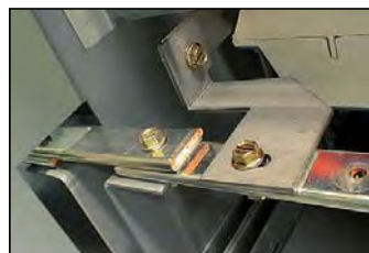
Figura 50 – Re-colocación del tornillo de la barra de tierra
