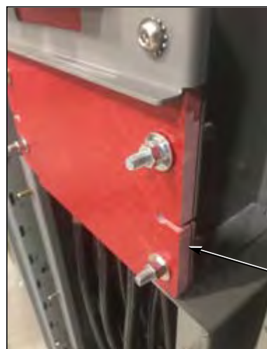
Figure 65 – Couvercle de cosses ArcBlok en place avant le liage
