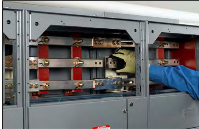
Figure 38 – Alignement des trous de l'ensemble de raccordement et de la barre-bus
