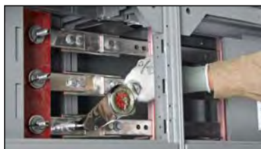
Figure 36 – Serrage des boulons
