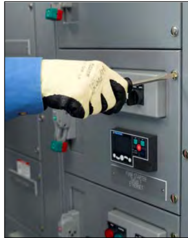
Figura 102 –Aflojamiento de los sujetadores cautivos
