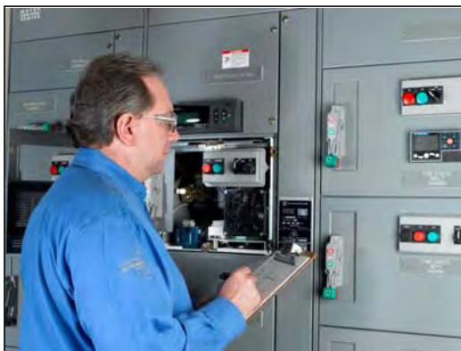
Figure 84 – Vérification avant la mise en service
