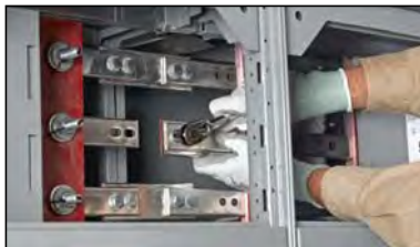
Figura 32 – Extracción de los tornillos de la barra de empalme sencilla
