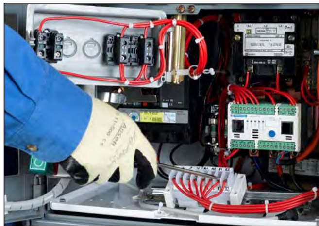
Figure 143 –Raccordement des fils de contrôle aux borniers
