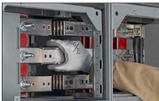
Figura 54 – Alineación de los agujeros de las barras
