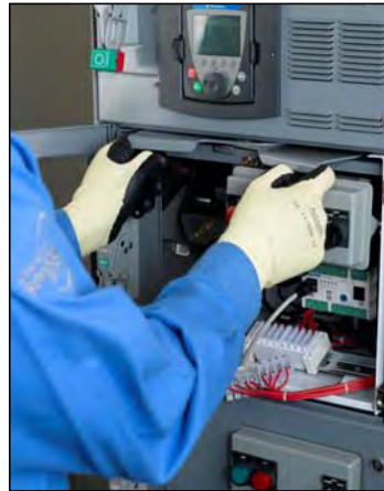
Figure 137 –Engagement du mécanisme des cames
