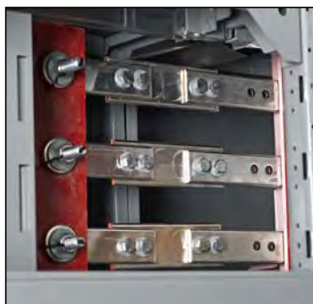
Figure 31 – Application incorrecte de raccordement à barre simple sur une barre-bus de type à fourche
