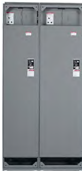
Figura 8B: Sin las cubiertas de canalización de cables horizontal superior
