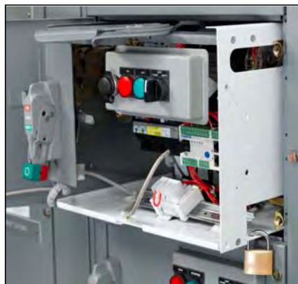
Figure 97 – Dispositif verrouillé
