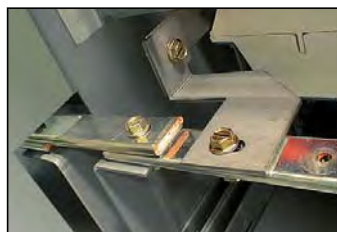
Figure 50 – Boulon de barre-bus de m.à.l.t. remis en place
