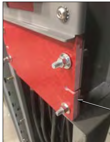
Figura 65 – Cubierta de la zapata del ArcBlok colocada antes de la sujeción
