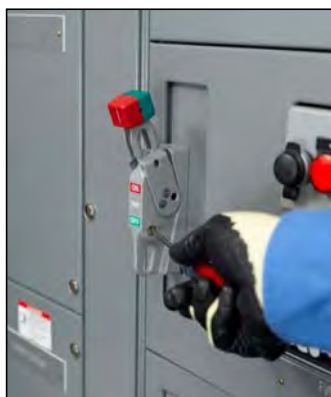
Figure 115 –Manœuvre du mécanisme de neutralisation de l'interverrouillage de porte
