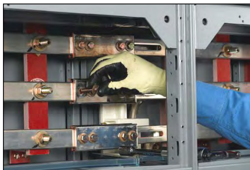
Figura 46 – Cómo introducir los tornillos de empalme
