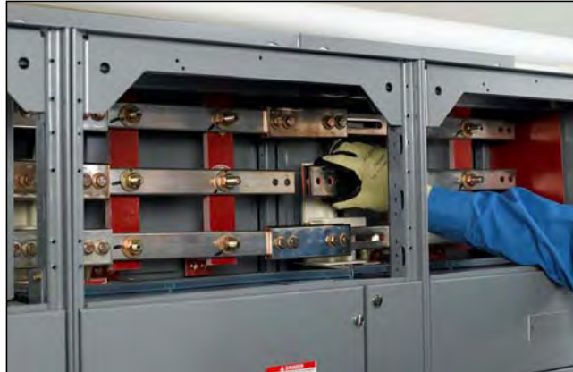
Figura 38 – Alineación de los agujeros de las barras de empalme y de distribución
