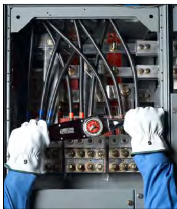
Figure 82 – Couple de serrage des connexions des compartiments des cosses principales
