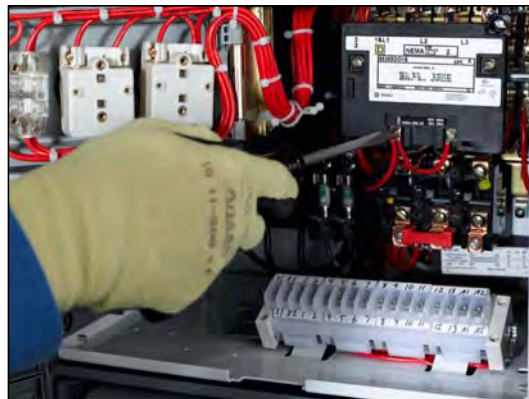
Figura 111 –Apriete de las conexiones eléctricas
