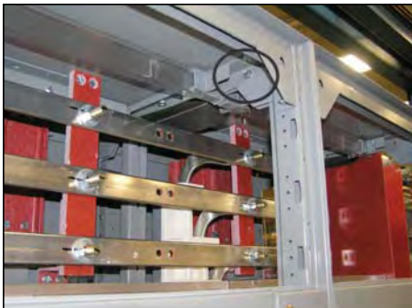
11F: Conexión del canal lateral superior frontal
