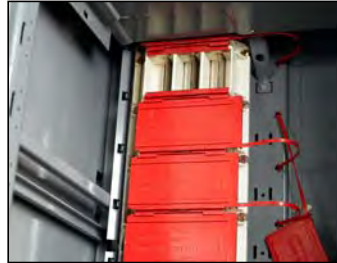
Figura 136 –Desmontaje de la persiana manual de la barra
