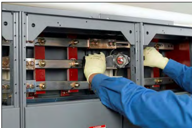
Figure 48 – Serrage de tous les boulons
