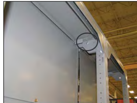
11G: Conexión del canal lateral superior trasero (se muestra con las placas traseras del CCM desmontadas)
