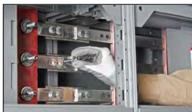
Figure 35 – Mise en place d'une rondelle conique sous la tête du boulon
