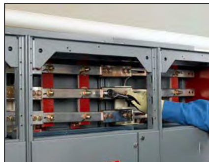
Figura 43 – Aflojamiento de los tornillos
