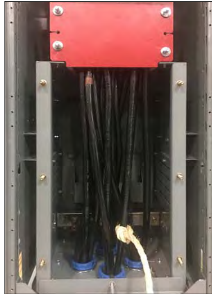
Figure 66 – Première boucle de liage des câbles
