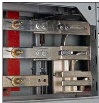
Figure 31 – Application incorrecte de raccordement à barre simple sur une barre-bus de type à fourche
