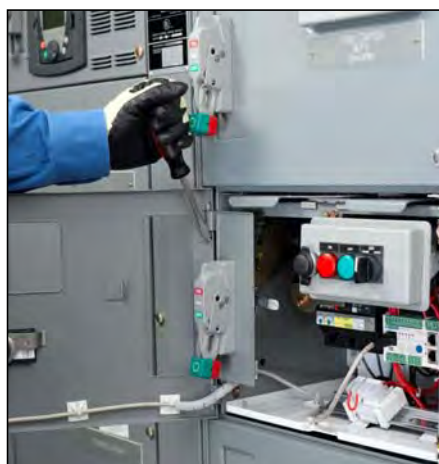
Figura 100 –Extracción del pasador de la bisagra
