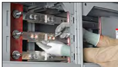
Figura 33 – Desplazamiento y alineación de la barra de empalme en los agujeros de la barra
