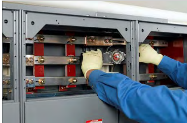
Figura 48 – Apriete de todos los tornillos
