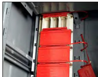
Figure 136 –Retrait de volet manuel des barres-bus
