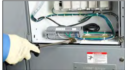
Figura 139 –Apriete de los herrajes del panel de bloqueo de la unidad de control (si fue provisto)
