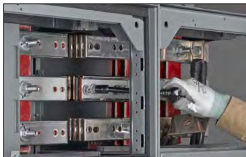
Figure 53 – Retrait des boulons de l'ensemble de raccordement
