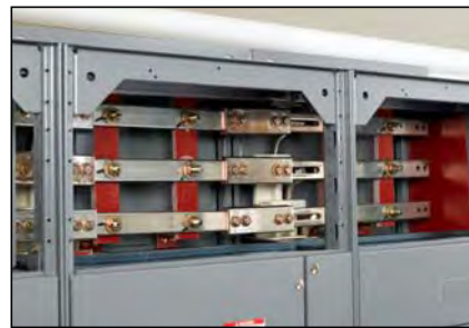
Figure 42 – Couvercles de la goulotte guide-fils retirés et écrans isolants de barres-bus horizontales ouverts
