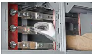
Figura 35 – Colocación de una roldana cónica debajo de la cabeza del tornillo
