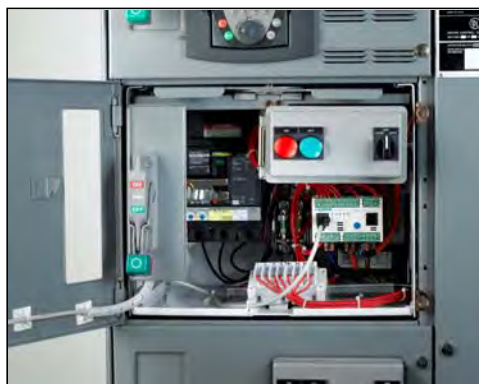
Figure 109 –Dispositifs de contrôle
