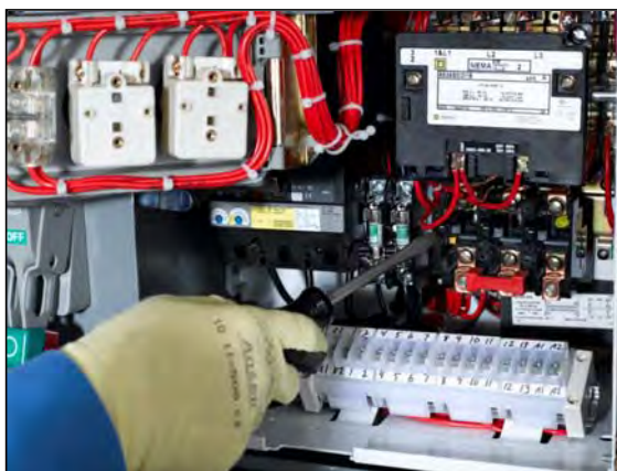
Figure 110 –Déclenchement du relais de surcharge
