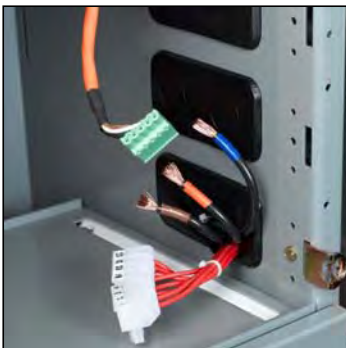
Figure 94 – Conducteurs d'alimentation et dessus des borniers passés par le port de câblage
