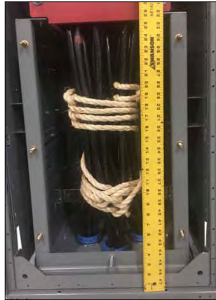
Figura 67 – Grupos de sujeción de cables superior e inferior
