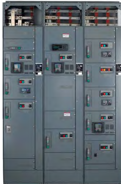
Figura 29 – Cubiertas de la canalización de cables horizontal y barreras de las barras retiradas
