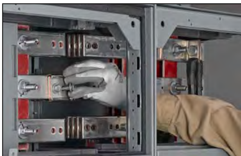
Figura 56 – Colocación de una roldana cónica debajo de la cabeza del tornillo
