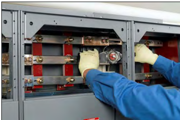
Figure 41 – Serrage des boulons
