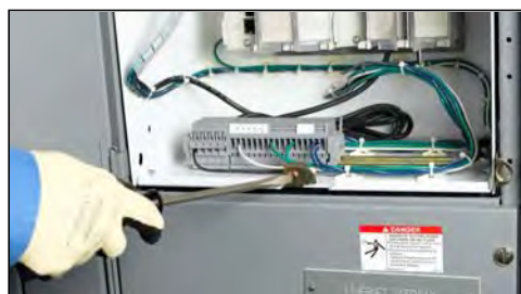
Figure 139 –Serrage du loquet de blocage de l'unité de contrôle (si fourni)
