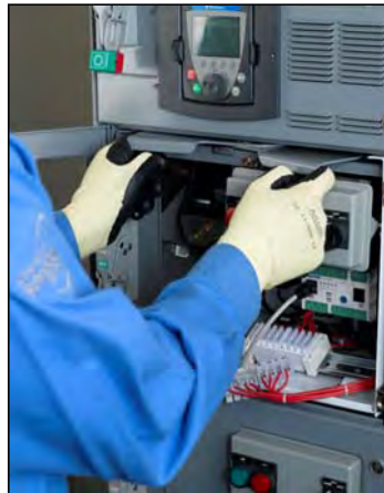
Figura 137 –Enganche del mecanismo de leva
