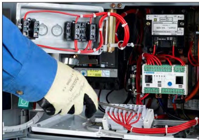
Figura 79 – Bloque de terminales desprendible
