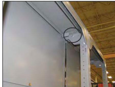
11G: Connexion du profilé latéral arrière supérieur (montrée avec les plaques arrière du CCM retirées)
