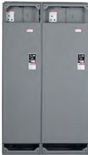
Figure 8B : Couvercles des goulottes guide-fils horizontales retirés
