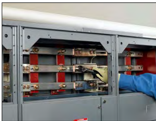
Figura 37 – Extracción de los tornillos izquierdos y aflojamiento de los tornillos derechos en el ensamble de empalme
