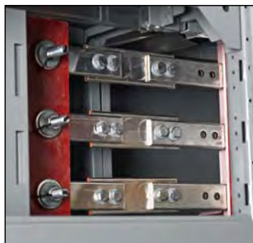
Figura 31 – Aplicación incorrecta de empalme de una sola barra en una barra tipo horquilla
