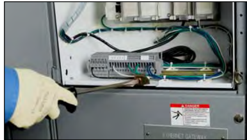
Figura 93 – Bloques de terminales desconectados
