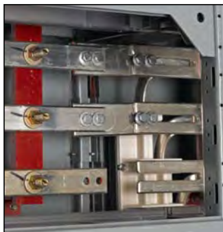
Figura 31 – Aplicación incorrecta de empalme de una sola barra en una barra tipo horquilla
