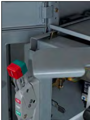
Figure 96 – Manœuvre de l'interverrouillage entre le mécanisme et la structure
