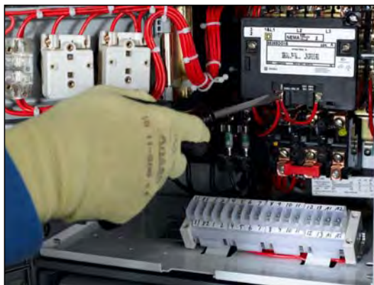
Figure 111 –Serrage des raccordements électriques
