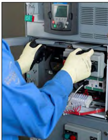
Figura 95 – Extracción del mecanismo de levas con palancas gemelas
