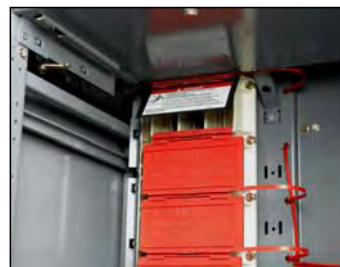
Volet automatique des barres-bus
