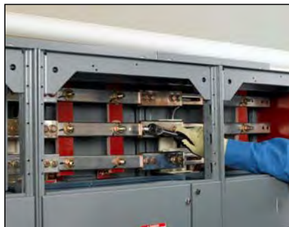
Figure 43 – Boulons desserrés
