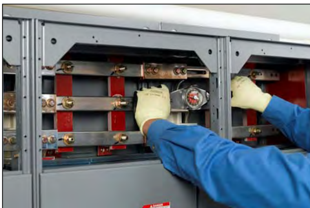
Figura 41 – Apriete de los tornillos
