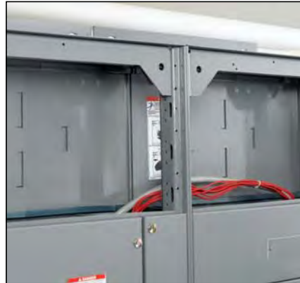
Figura 77 – Alambrado en la canalización de cables horizontal superior
