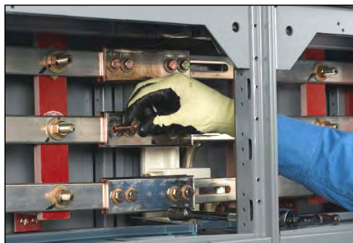
Figura 40 – Colocación de una roldana cónica debajo de la cabeza del tornillo
