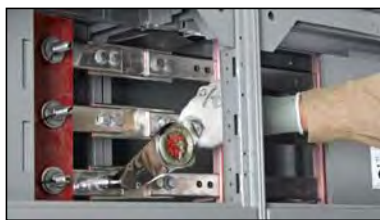
Figura 36 – Apriete de los tornillos
