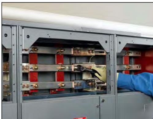
Figure 37 – Retrait des boulons de gauche et desserrage des boulons de droite sur l'ensemble de raccordement
