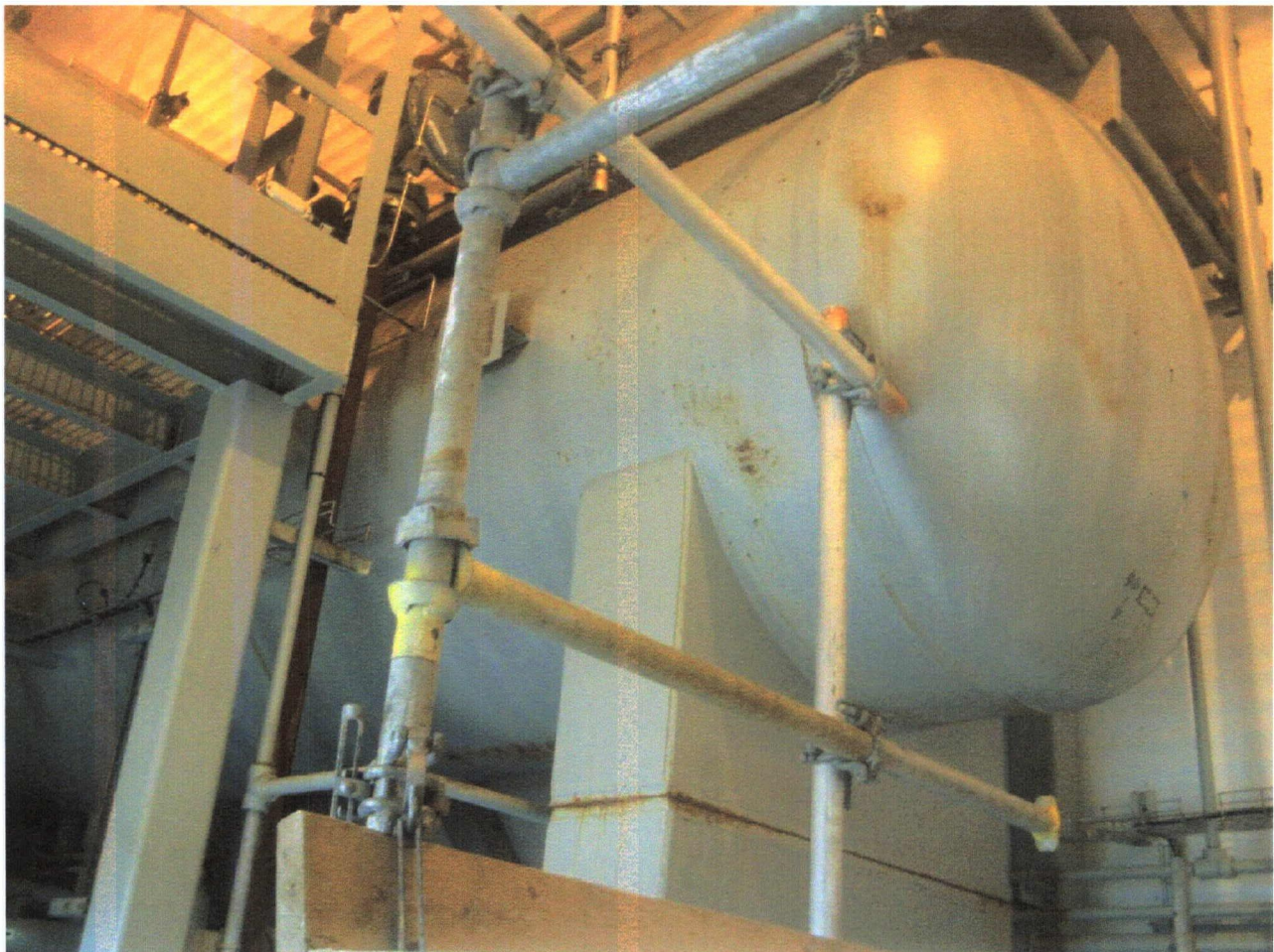
PID-011 INLET SEPERATOR
